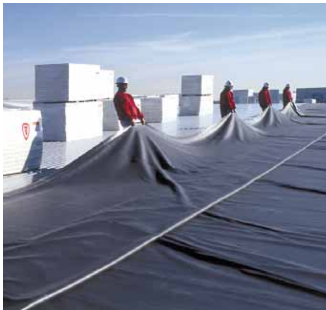
Aplicación en una cubierta de grandes dimensiones
